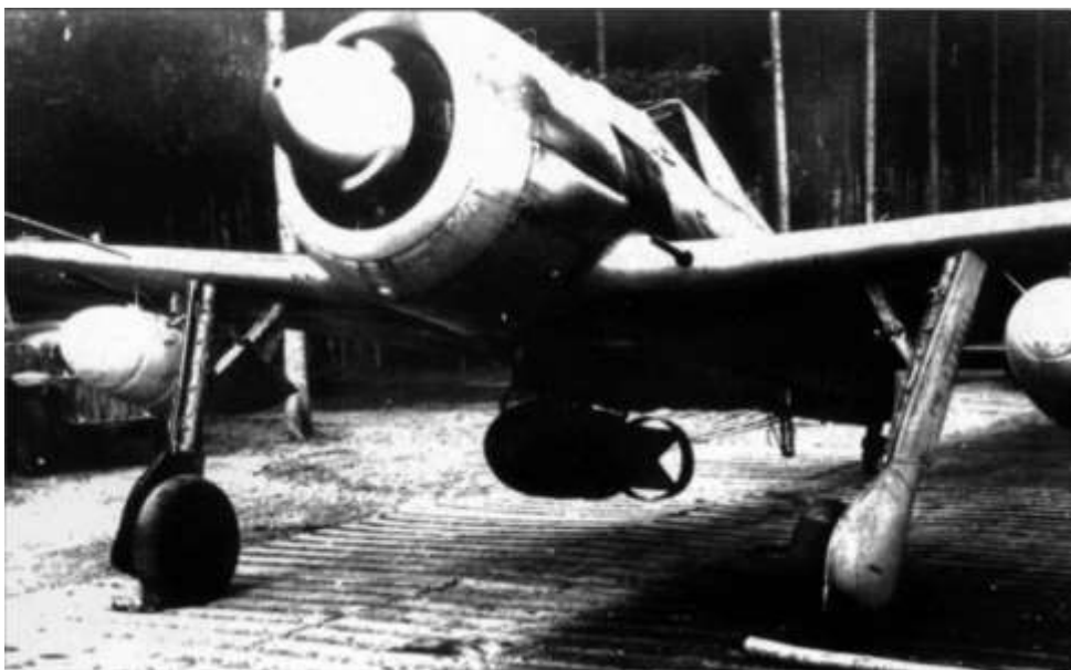
Fw 190 fra NSGr 20 under taxi på egen flyveplads. Under bugen medfører flyet en 500 kg sprængbombe og under vingerne droptanke med brændstof. Om aftenen den 2. marts mistede NSG 20 en Fw 190 under angreb på jordmål i nærheden af Goch.
